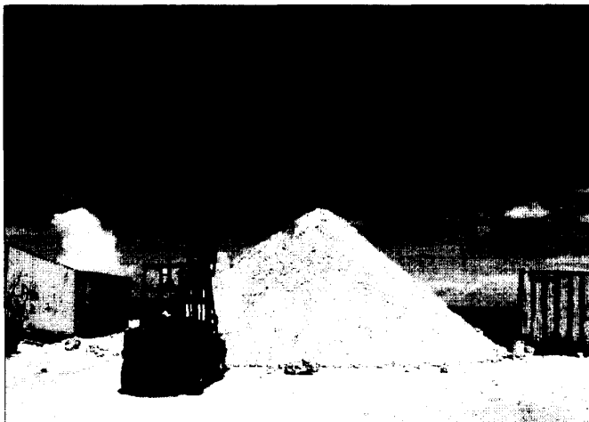
写真6 埋立て工事はなかなか進まない。(筆者撮影)
