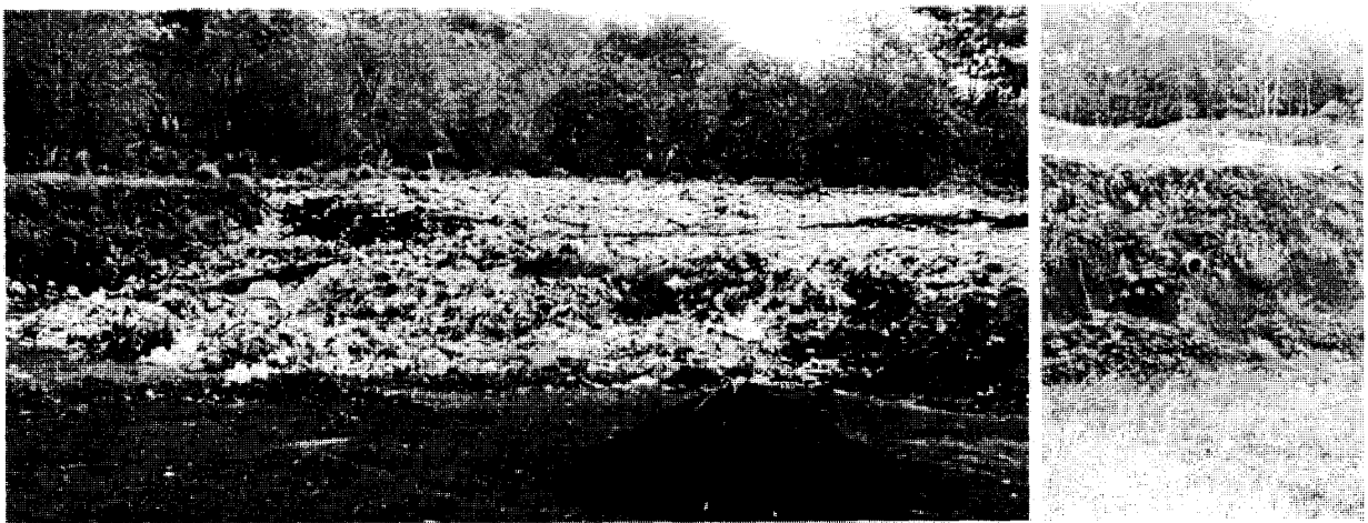
図7 埋立は勾配のもっとも高い区画から始まった。すでに中央のガス抜き管のあたりまで来ている。ちょうど覆土のための土が運ばれているところだった。右は、浸出水を流し込むための溜め池につき出した集排水管の出口。微生物を活性化させる空気の進入口の役割もする。 2003年9月 筆者撮影
