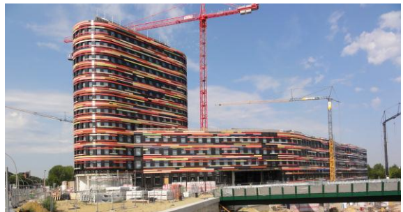
図 8 建設中の都市開発環境省の新庁舎 (2012. 9.10 筆者撮影)
