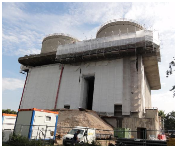
図9 保存改修中のエネルギー・トーチカ
