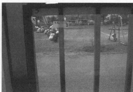
柵の面にクリアボードをテープで張って覆う
