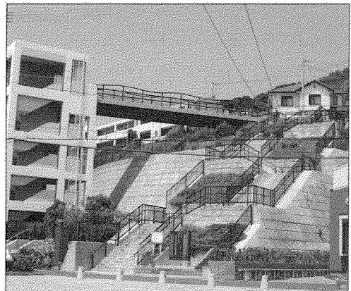
写真3 新たな「がんぎ段」と集合住宅
