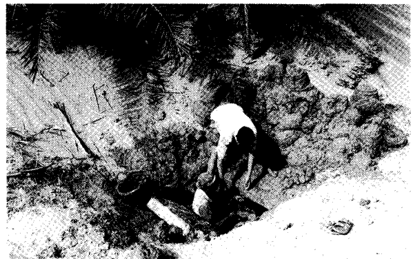
写真4 ジョルフ村エル・ブーヤ地区のハッターラ導水路(図4-⑥)の浚渫作業(2001年7月)
